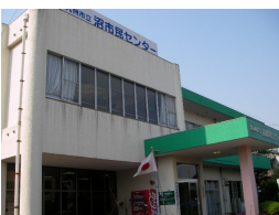
市民センター外観
