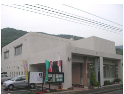
市民センター外観
