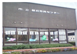
市民センター 外観
